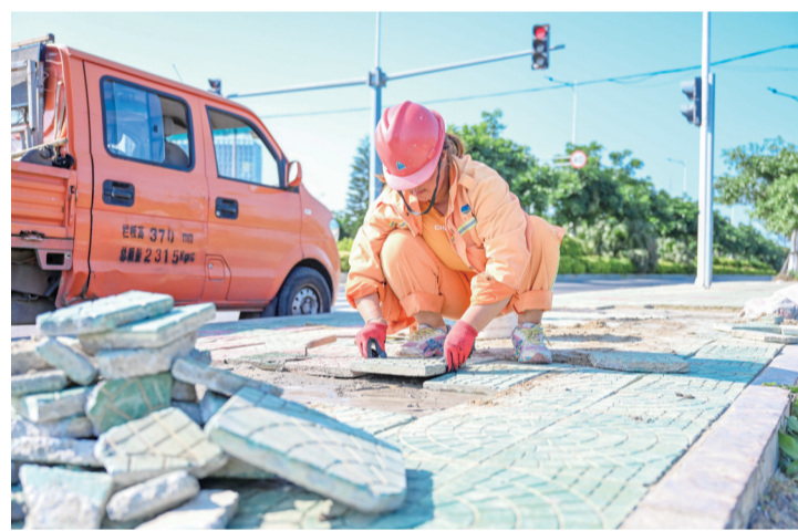
工作人员修复人行道。融媒体记者 林君斌 摄
